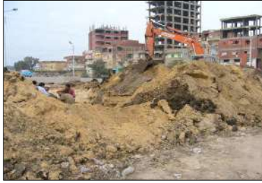
صورة (٤) بعض أعمال الحفر والردم التي تتعرض لها شبكة الشوارع بالمدينة
