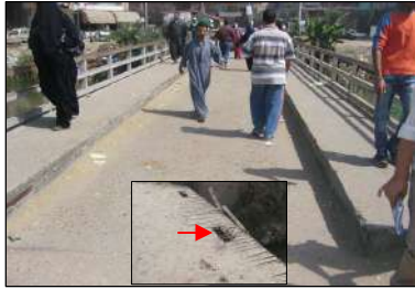
صورة (٦) سوء الحالة الفنية لمعبر مبيت علوان وعدم صلاحيته لمرور المركبات
