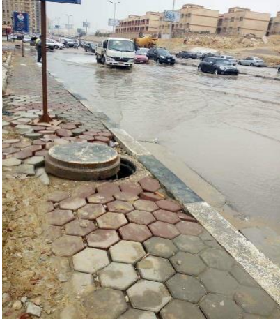
صورة (٣): تفاوت مناسيب بيارات الصرف مع مسارات المياه، ٢٠١٦م
