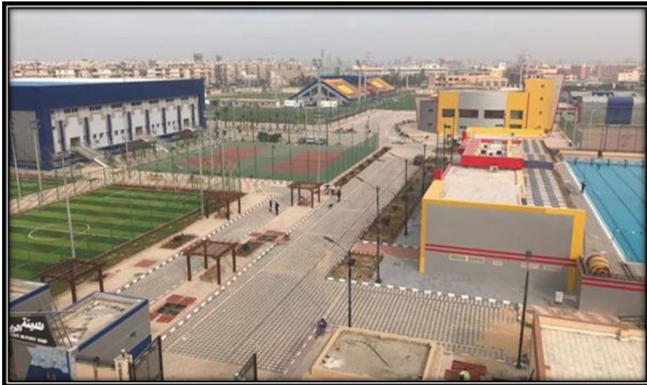
الصورة (١) المدينة الأولمبية في حي الضواحي محافظة بورسعيد عام ٢٠٢٢.
