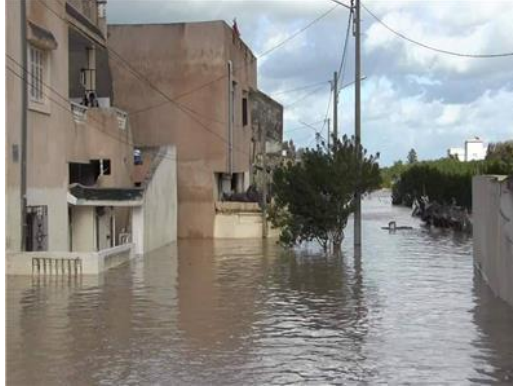
صورة (١): ارتفاع منسوب المياه في المناطق السكنية، حي التجمع الخامس، ٢٠١٦م
