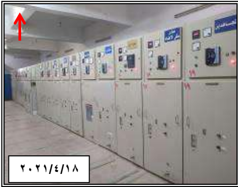
صورة (٤) مغذيات الخروج بلوحة توزيع الخارجة.
