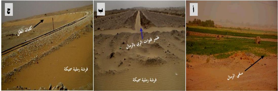
أ- سفي الرمال على الأراضي الزراعية بقرية بغداد ب- زحف الرمال على قنوات الري بالأراضي المستصلحة ج- كثبان الظل والفرشات الرملية بامتداد الخط الحديدي قنا/الخارجة
