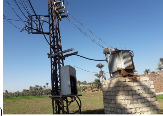
ورة-٩) المحولات الكهربائية المتهالكة
