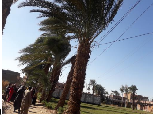
صورة -١٠) أسلاك الكهرباء على ارتفاع منخفض
